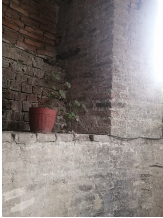
Mampostería nivel inferior de la torre, muros y columnas de mampostería
